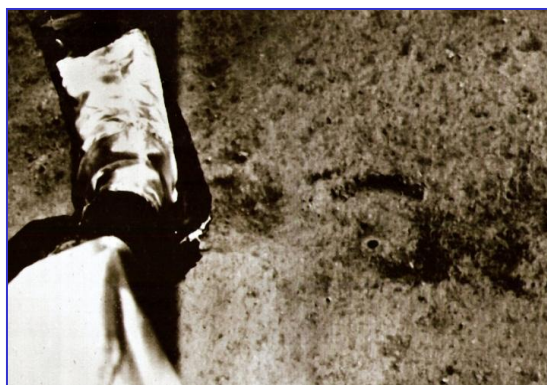
Рис. 7. Свидетельство успешной работы грунтозаборного устройства «Луны-20». На снимке чётко видна цилиндрическая вмятина, оставленная торцом бурового снаряда, а в центре – отверстие от извлечённой буровой колонки
